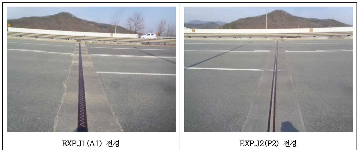
【사진 2.3.16】 신축이음장치 전경
