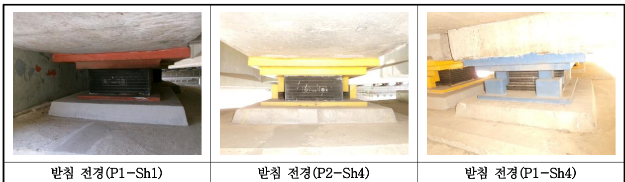
【사진 2.3.12】 교량받침 전경
