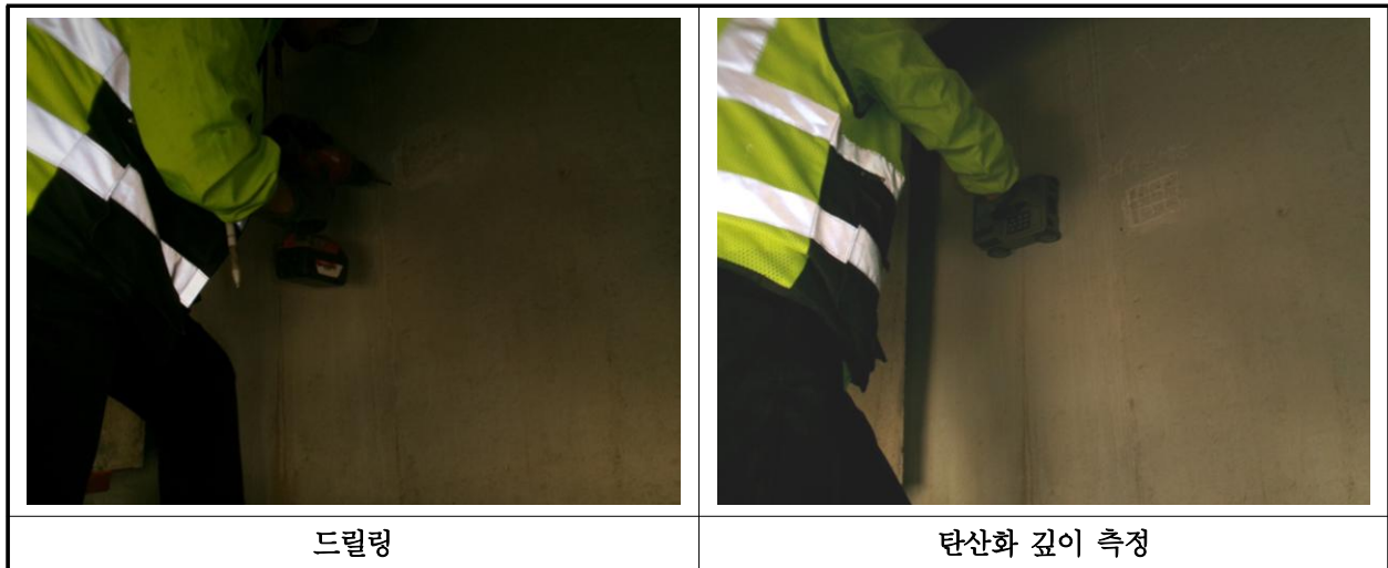
【사진 2.4.2】 탄산화 깊이 측정 현장사진
