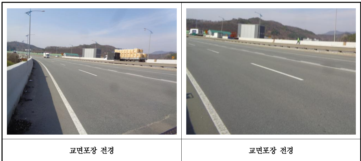
【사진 2.3.19】 교면포장 전경
