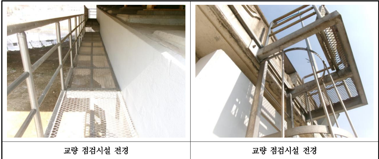
【사진 2.3.25】 교량 점검시설 전경
