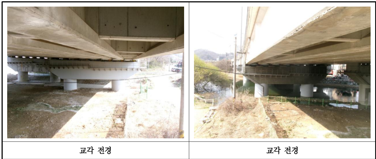
【사진 2.3.10】 교각 전경
