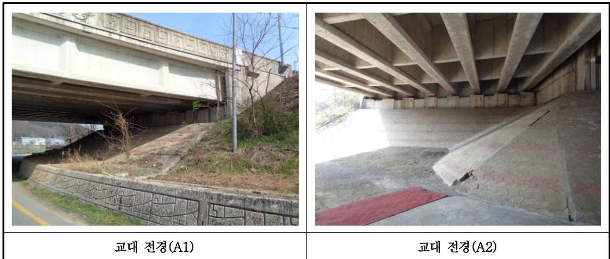
【사진 2.3.8】 교대 전경
