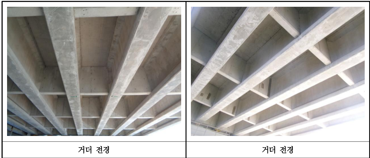
【사진 2.3.4】 거더 전경
