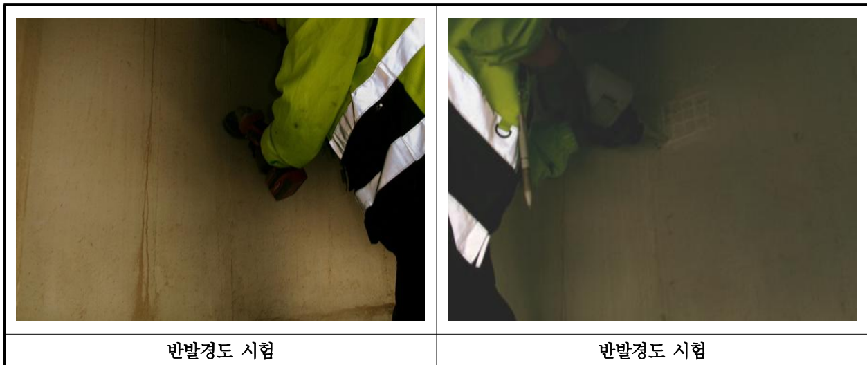
【사진 2.4.1】 반발경도시험 현장사진
