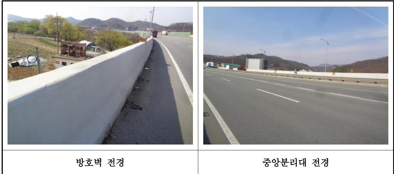
【사진 2.3.23】 난간 및 연석 전경
