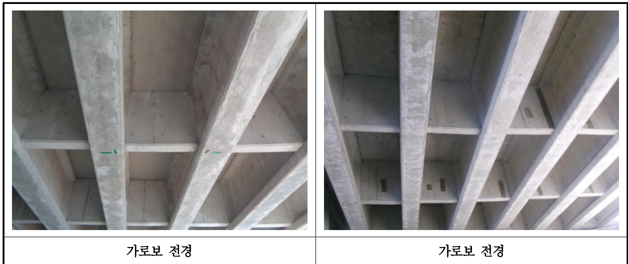
【사진 2.3.6】 가로보 전경
