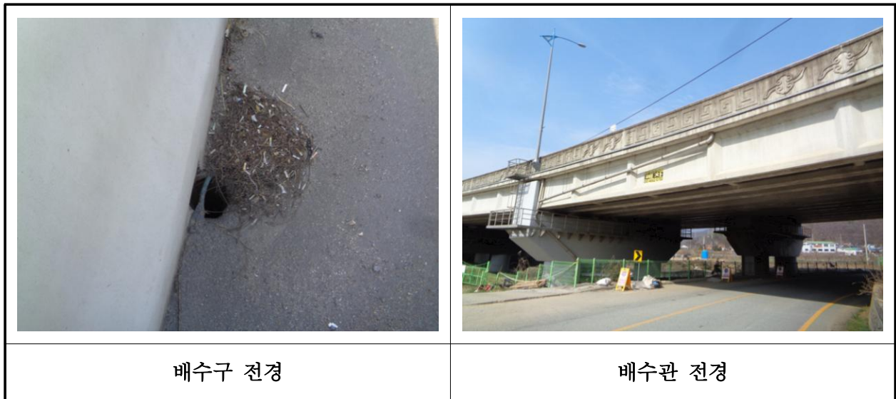
【사진 2.3.21】 배수시설 전경
