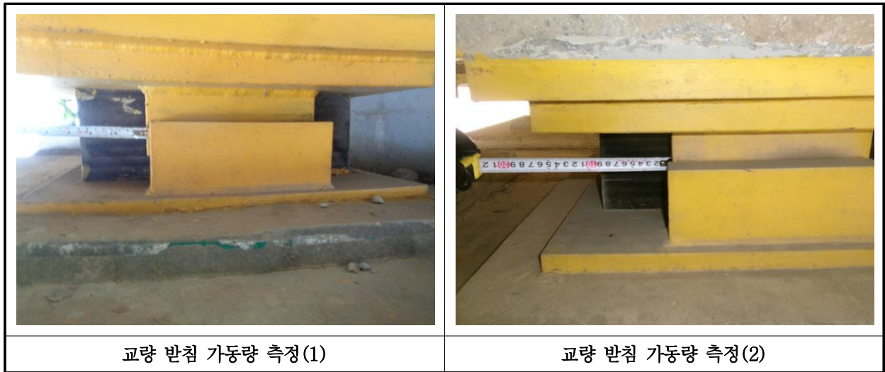
【사진 2.3.15】교량받침 이동량 측정
